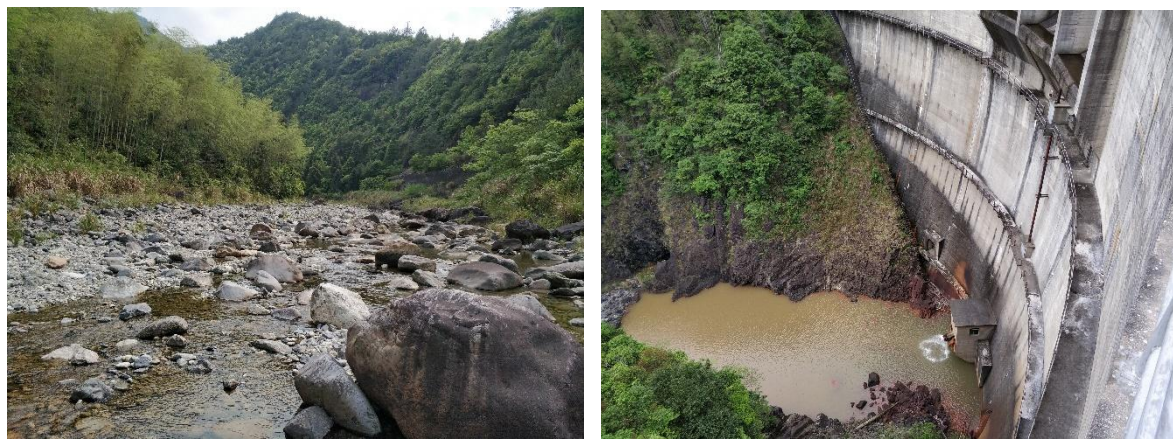
图3.6.2-1 均溪二级电站厂坝间河道及大坝生态放水情况
