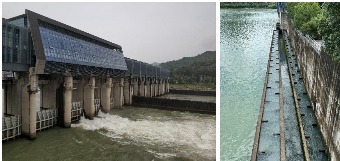
图3.6.6-1 沙头拦河闸及鱼道
